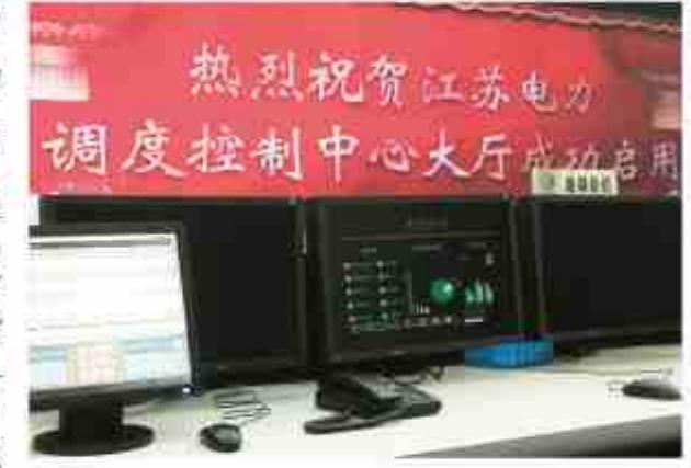
新大厅的调度通信系统由我公司承建。大厅内分布了15席PM600型触摸屏调度台，这些调度台与省调交换机和镇江备调交换机连接，实现双机同组运行模式，保证调度通信的可靠性。年底，江苏电力软交换调度平台搭建之后，PM600调度台同时与软交换平台连接，实现电路交换与软交换的多机同组模式。两种技术手段，保障了电力调度通信先进性和安全性需要。
